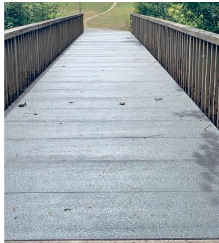
Nachher: Minimiere Sturzgefahr durch rutschhemmende Beschichtung der GFK-Planken
