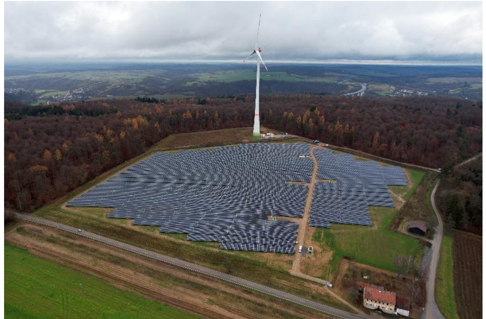
Hybridpark der BürgerEnergie Widdern: Freiflächen-Photovoltaik & Windenergie versorgen unter anderem die Wasserstoffherzeugung am DLR. Das verfallene Gebäude unten rechts wird mit Erlösen der FF-PV saniert und als Infozentrum und Versammlungsstätte ausgebaut.
