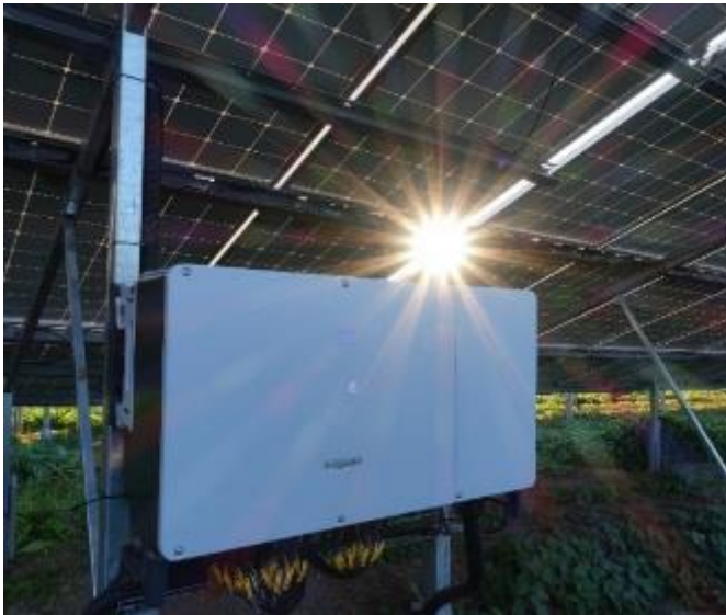
Herzstück: Wechselrichter im Schatten der Module
