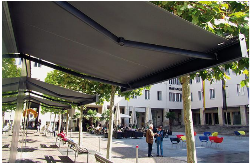
Moderne Markisen entlang der Fassadenöffnungen
