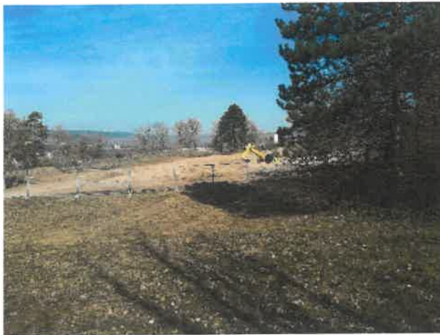
9) Abgeräumte Fläche und Kiefer © Klärle GmbH, 21.03.2025
