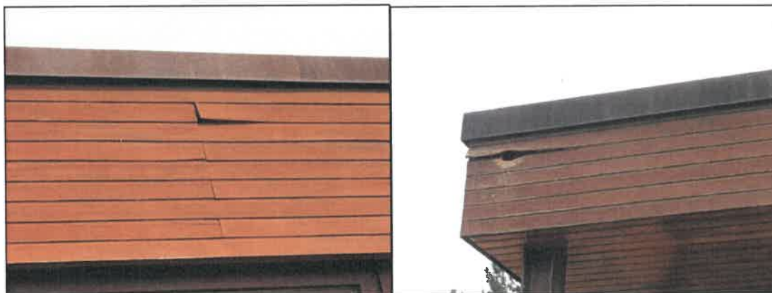
Abbildungen 9 und 10: Beispiel für Öffnungen/Löcher in Holzverkleidungen an Dächern im geplanten Sondergebiet.
