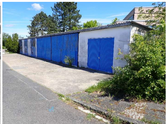
2) Ältere Gebäude © Klärle GmbH, 20.05.2025
