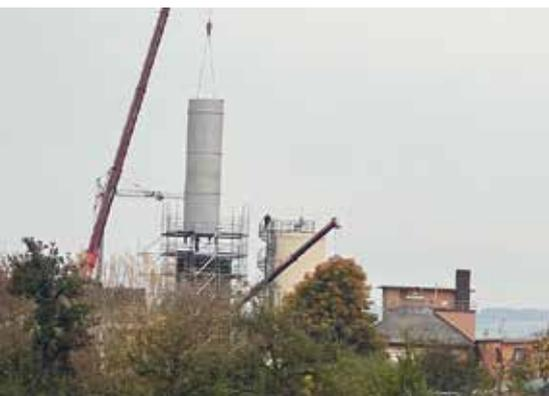
Die Sanierung der Kläranlage geht Stück für Stück voran. Für den Neubau des kuppelförmigen Gasbehälters ist eine gute Basis geschaffen worden. Die Arbeiten am Fundament sind abgeschlossen. Im zweiten Faulturm ist das 15 Meter lange Leerrohr montiert und das Kopfteil ist montagebereit. Die Betonsanierungsarbeiten im Zulaufbewerk sind abgeschlossen und die neuen Hebeschnecken im Zulaufbewerk montiert. Für die Inbetriebnahme des Zulaufbewerks fehlen noch einzelne Programmierarbeiten.
