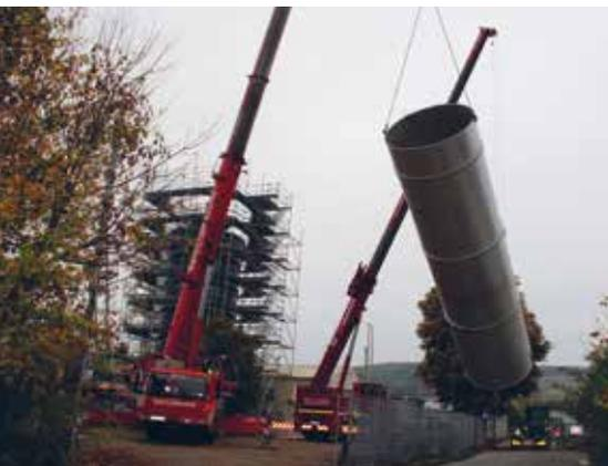
Das Leerrohr ist 15 Meter lang und hat einen Durchmesser von 3 Metern.
