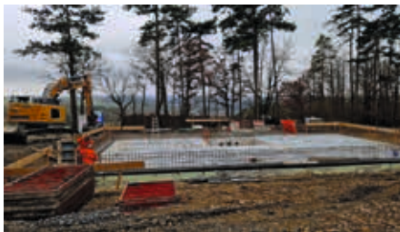
Baustelle Trinkwasser-Hochbehälter Hof Steinbach
